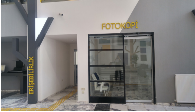
Resim 22. Açılır-kapanır kapı. (Engelli Kullanım İmkanları, 2019)
