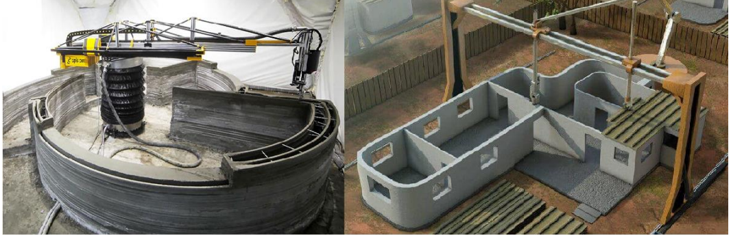
Resim 8: 3B Yazıcının İnşaat sektöründe kullanımı
