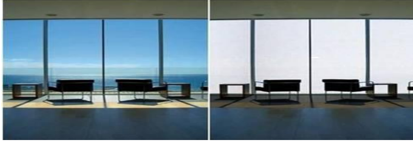
Resim 22: Akıllı cam, iklime uyum için ışık iletimi üzerinde kontrol sağlar
