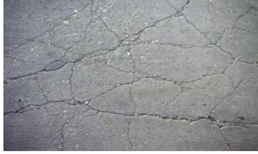
Resim 21: Kendi çatlaklarını iyileştirmeden önce akıllı beton
