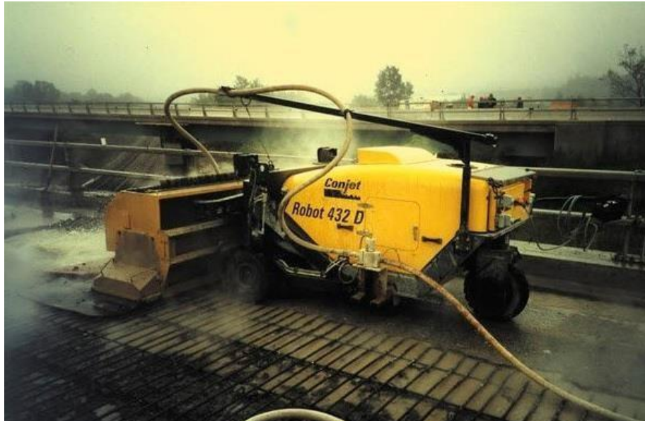
Şekil 20: Su Jeti ile Betonarme Yapı Yıkımı [43]
