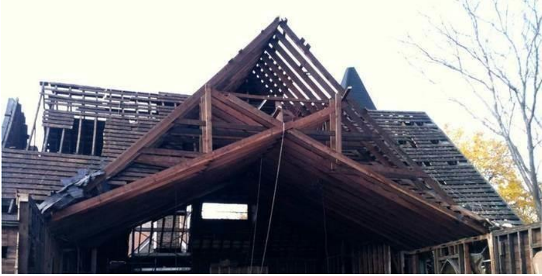
Şekil 14: Çatı Sökümü [34]
