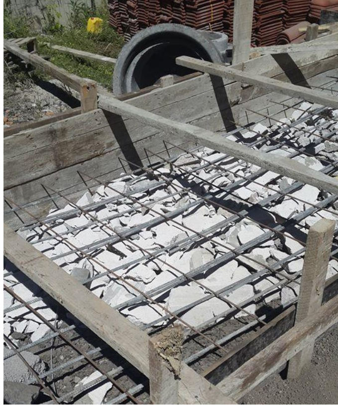
Şekil 24: Beton Yapısal Atıkların Blokaj Olarak İkincil Kullanımı
