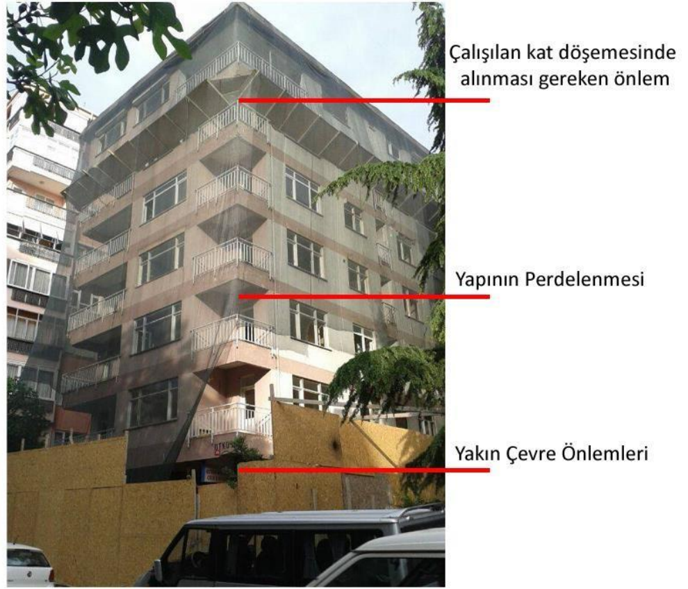
Şekil 23: Yapıların Söküm – Yıkım Önlemleri
