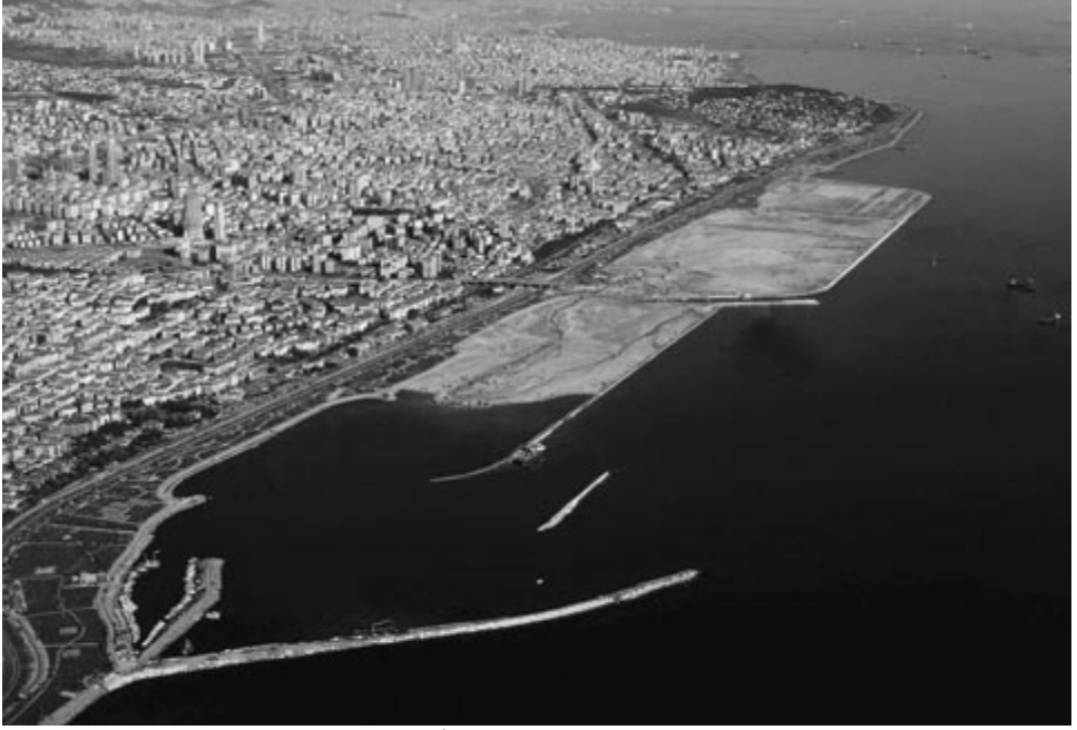
Görsel 6: Maltepe Dolgu Alanı Projesi İnşa Halinde (2013).
