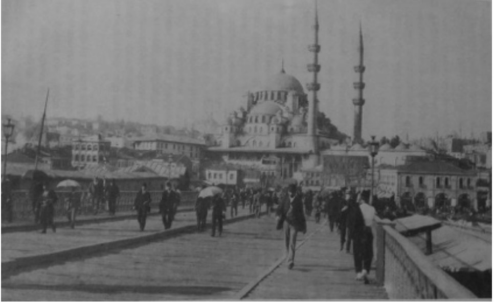
Görsel 3: Demir Konstrüksiyonlu ve Ahşap kaldırımlı Üçüncü Galata Köprüsü (1878).
