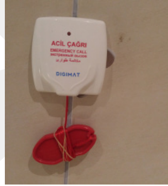
Resim 14. Acil çağrı sistemi. (Engelli Kullanım İmkanları, 2019)
